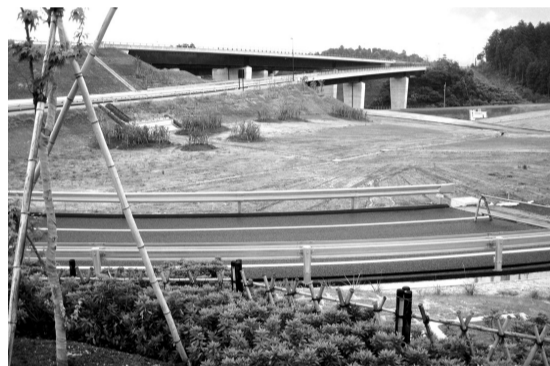
甲南インターチェンジ工事現場
