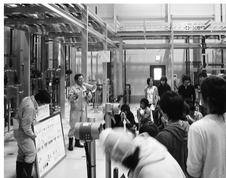
クリーンセンター滋賀：浸出水処理場内での説明
